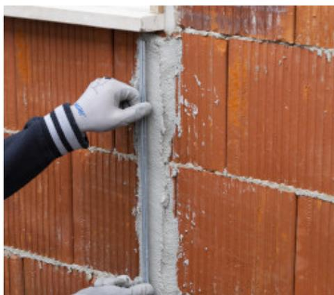
Posizionamento delle guide verticali
