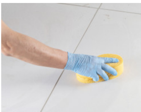
Pulizia e finitura delle fughe con spugna di cellulosa dura
