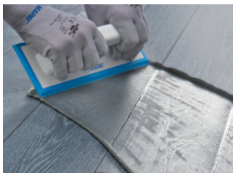
Stesura di Ultracolor Plus a pavimento con spatola di gomma su piastrelle in gres porcellanato effetto legno
