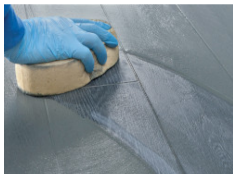
Pulizia e finitura delle fughe con spugna di cellulosa dura
