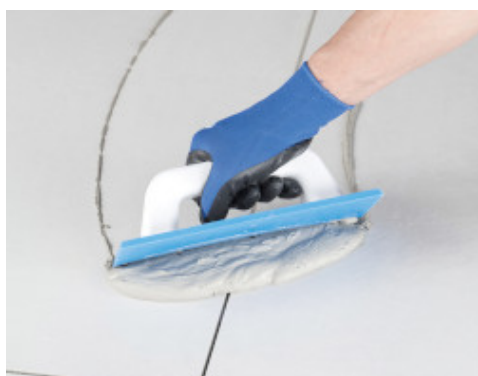
Stesura di Ultracolor Plus a pavimento con spatola di gomma su piastrelle in gres porcellanato
