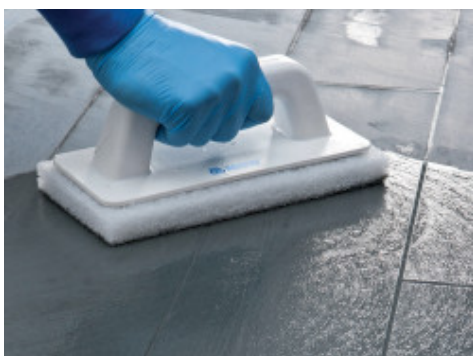
Pulizia delle fughe con Scotch-Brite® (a prodotto parzialmente indurito)
