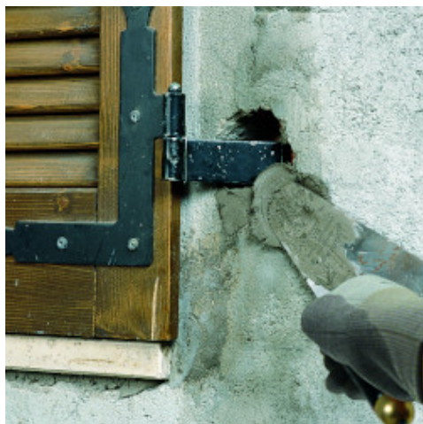
Posa di zanche per finestre con Lampocem
