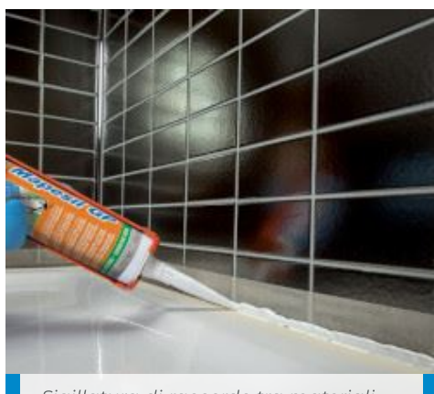
Sigillatura di raccordo tra materiali differenti
