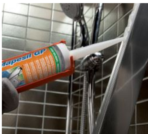
Incollaggio di profili metallici
