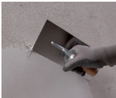
Stesura di un primo strato di Mape-Antique FC Ultrafine
