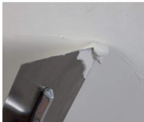
Lisciatura del prodotto con spatola metallica piana
