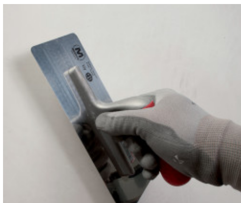
Stesura di un secondo strato di Mape-Antique FC Ultrafine
