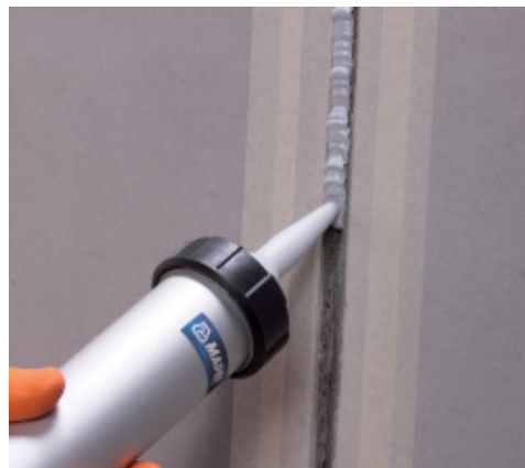
Applicazione di Mapeflex PU40
