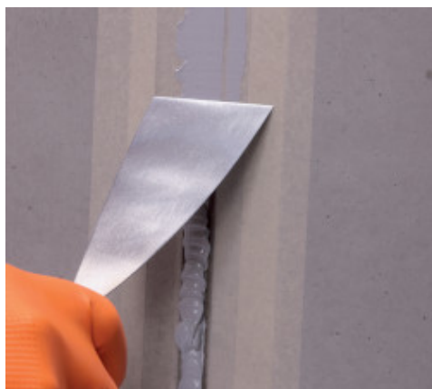
Lisciatura di Mapeflex PU40
