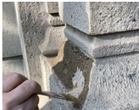
Consolidamento di elemento architettonico con Primer 3296 applicato a pennello
