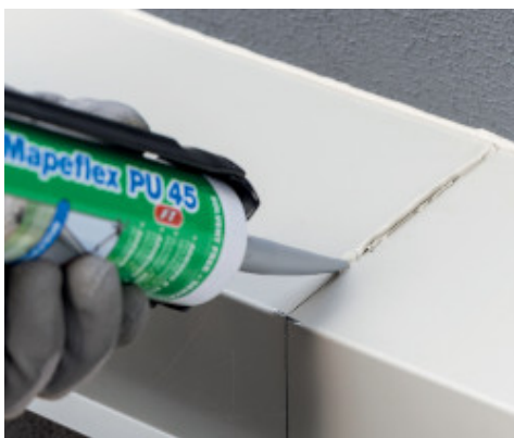
Sigillatura elastica di giunti di costruzione
