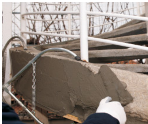
Applicazione a mano di Mapegrout 430 Zero
