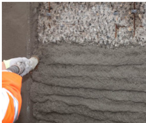
Applicazione a spruzzo di Mapegrout 430 Zero
