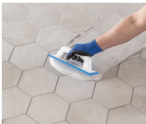
Stesura di Keracolor FF con spatola MAPEI
