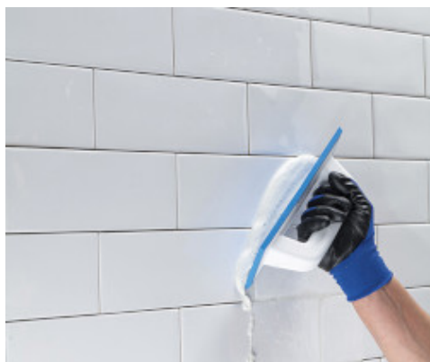
Stesura di Keracolor SF con spatola MAPEI
