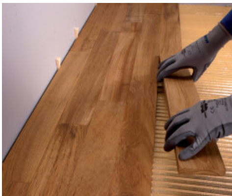
Posa di parquet di grande formato
