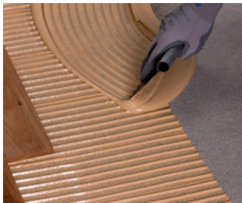
Posa di parquet massiccio su sottofondo in Topcem
