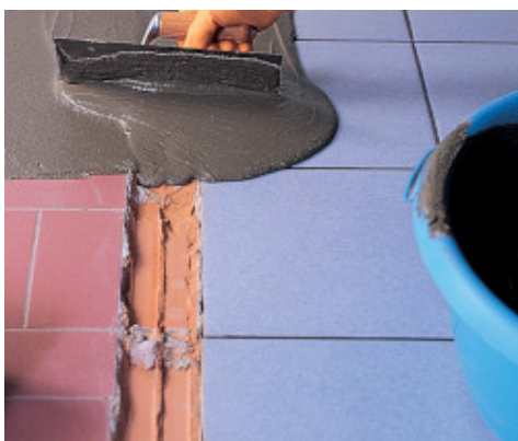
Rasatura di vecchie pavimentazioni con Adesilex P4
