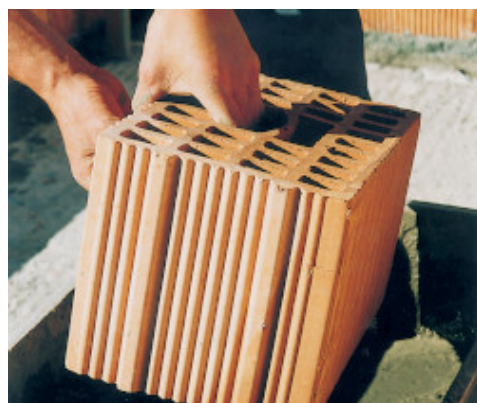
Immersione del blocco in laterizio nell'Adesilex P4
