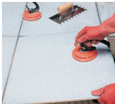
Posa di grande formato
