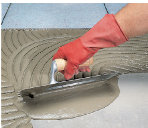
Stesura con spatola a dente semicircolare
