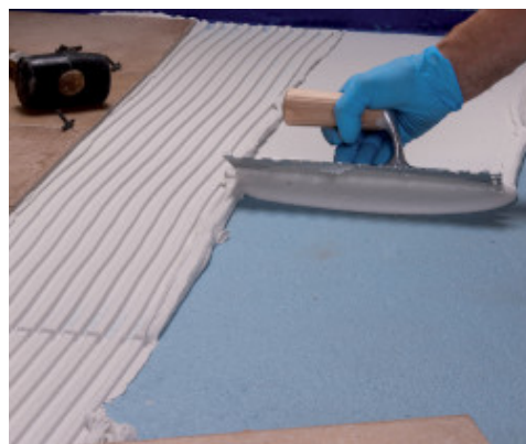
Incollaggio delle piastrelle su Mapelastic AquaDefense Zero
