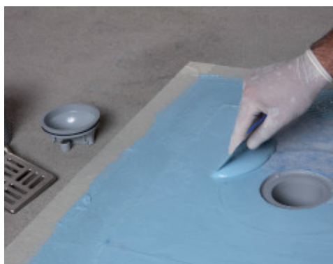
Ammorsamento del tessuto di Drain Vertical con Mapelastc AquaDefense Zero
