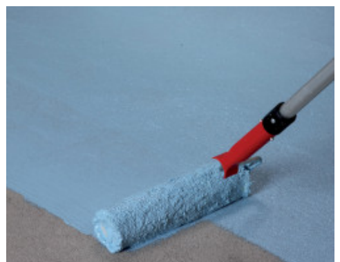
Applicazione della prima mano di Mapelastc AquaDefense Zero su massetto
