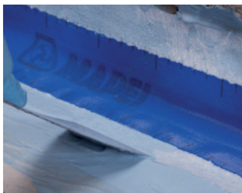
Applicazione di Mapeband nel raccordo parete-pavimento con Mapelastc AquaDefense Zero
