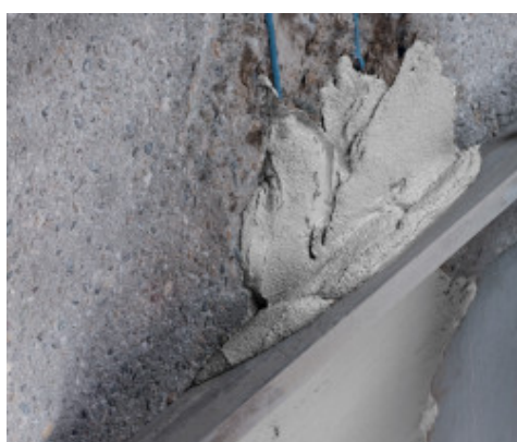
Staggiatura di Planitop Rasa & Ripara Zero
