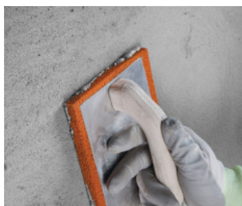
Frattazzatura di Planitop Rasa & Ripara Zero
