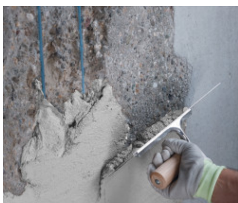
Applicazione a spatola di Planitop Rasa & Ripara Zero
