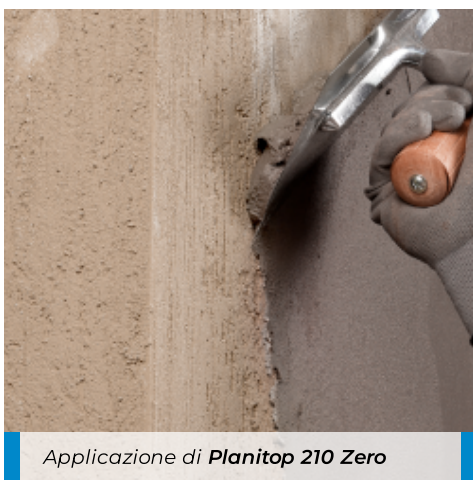
Frattazzatura di Planitop 210 Zero
