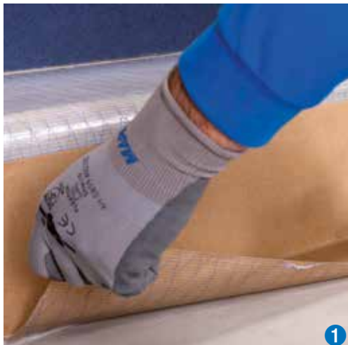
Posizionamento di Mapecontact sulla alzata del gradino
