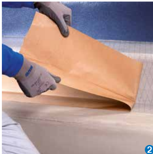
Rimozione del liner protettivo
