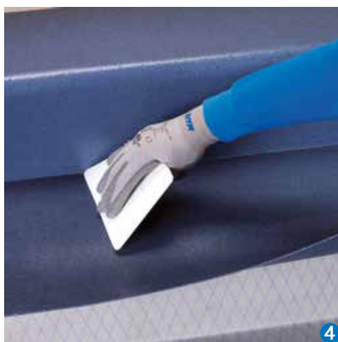
Massaggiatura del PVC dopo applicazione su Mapecontact
