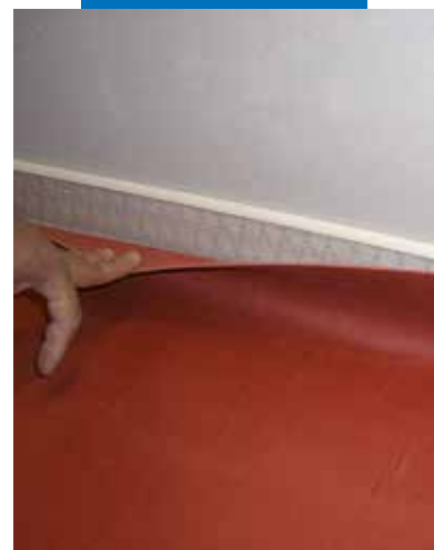
Realizzazione di sguscia mediante utilizzo di Mapecontact
