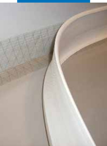
Posa di zoccolino in PVC plastificato mediante utilizzo di Mapecontact
