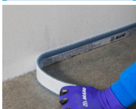
Dopo la posa della pavimentazione finale rifilare la parte eccedente di **Mapesilent Band R**.
