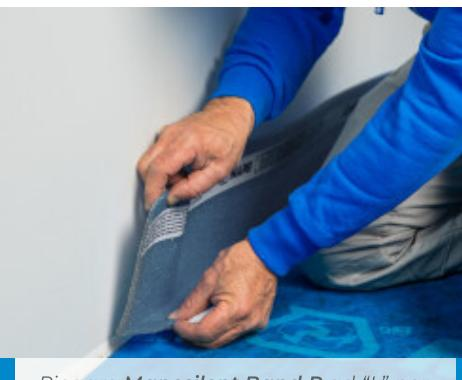
Piegare **Mapesilent Band R** ad "L" per formare un angolo di 90° e, partendo da metà parete, procedere all'incollaggio della base al supporto.
