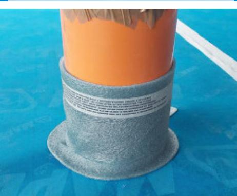
Applicare **Mapesilent Band R** in corrispondenza delle tubazioni che attraversano il solaio.
