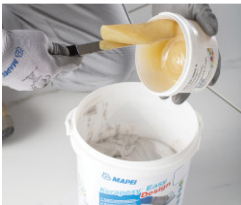
Versare l'induritore (componente B) nel contenitore del componente A
