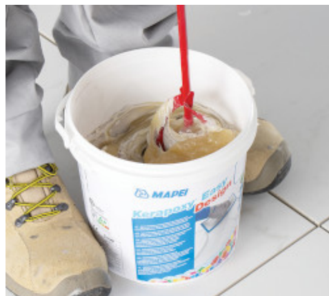
Miscelare i componenti (A+B)
