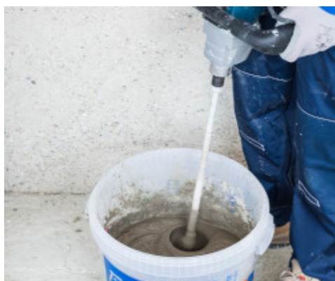
Miscelazione di Planitop Rasa & Ripara R4 Zero
