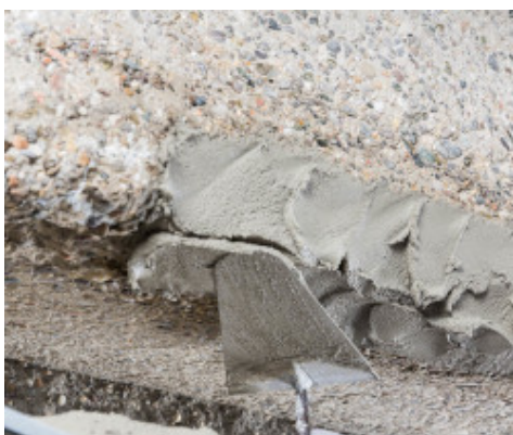
Applicazione di Planitop Rasa & Ripara R4 Zero
