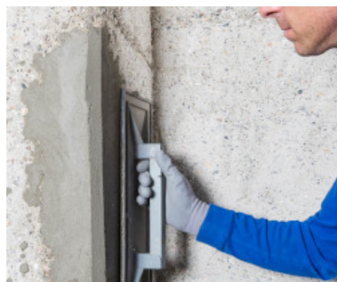
Frattazzatura di Planitop Rasa & Ripara R4 Zero
