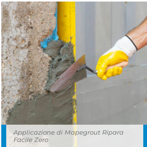
Frattazzatura di Mapegrout Ripara Facile Zero
