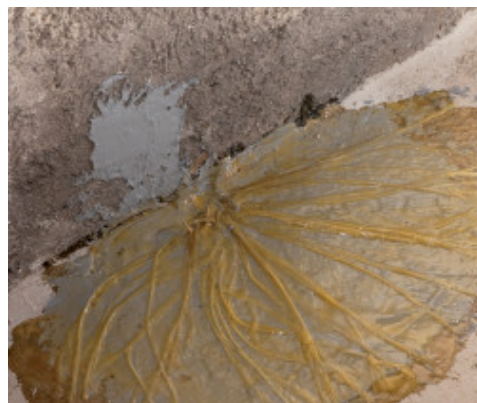
Impregnazione di MapeWrap FIOCCO
