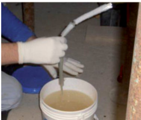
Impregnazione di una porzione di MapeWrap FIOCCO
