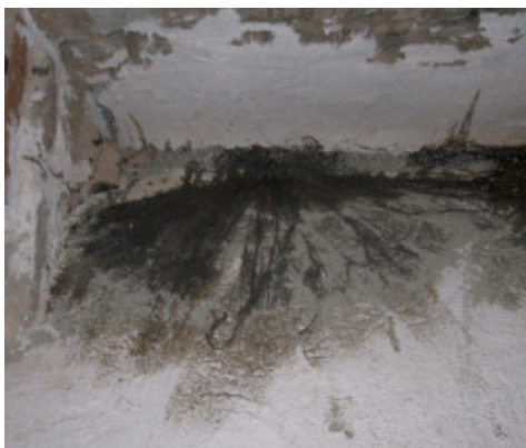
Connessione puntuale realizzata mediante MapeWrap B FIOCCO
