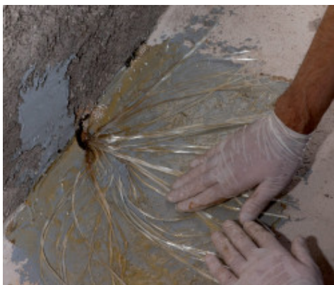
Apertura a ventaglio di MapeWrap FIOCCO
