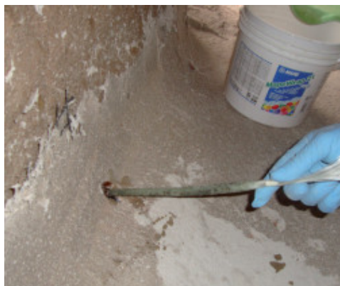
Inserimento di MapeWrap FIOCCO nel foro
