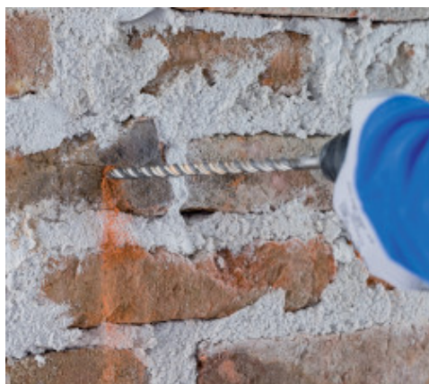
Realizzazione dei fori
