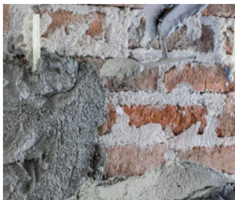
Applicazione del primo strato di malta
