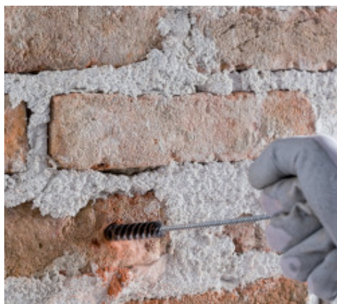
Asportazione delle polveri dai fori
