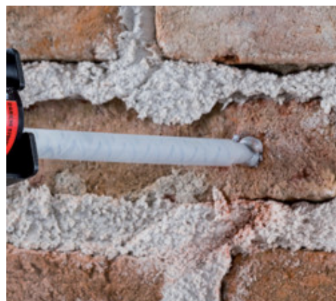
Applicazione di fissaggio chimico
