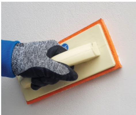
Rifinitura con frattazzino di spugna di PoroMap Finitura Civile
