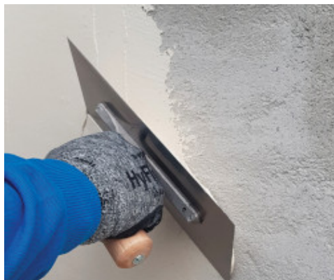
Applicazione di PoroMap Finitura Civile su intonaco stagionato
